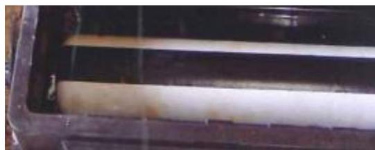
ITB取り付け後、上記写真の通りに防食テープを巻き、緩衝材を装着した後、合わせ部分に防食テープを貼ってください。
