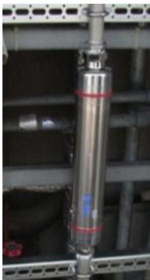
接続配管に重量負荷をかけないように、必ず、支持固定を施して下さい。
