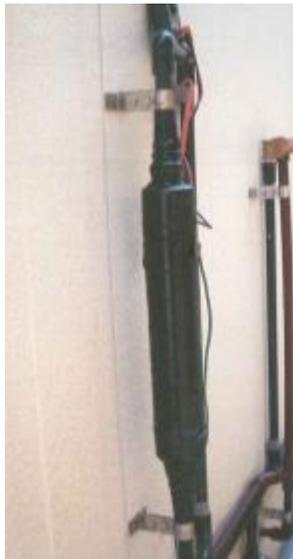
露出配管の場合、緩衝材が外れないように、防食テープを接続部分だけではなく、緩衝材も巻いてください。
